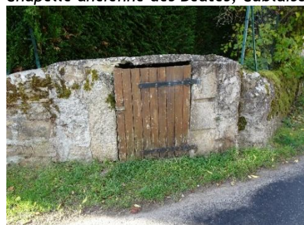
Puits de Cublaise
