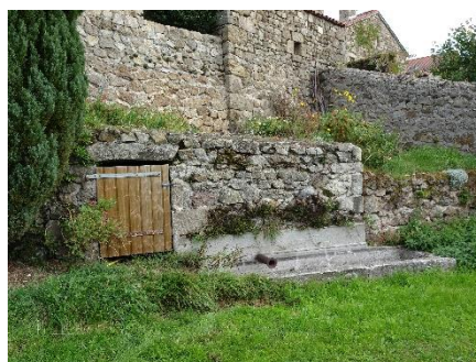
Puits de Blassac
