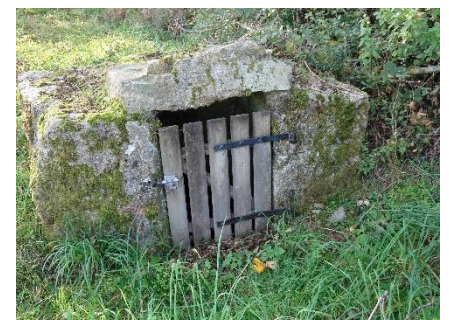
Puits proche du Lavoir
