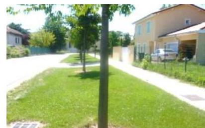
Exemple de traitement des eaux pluviales
